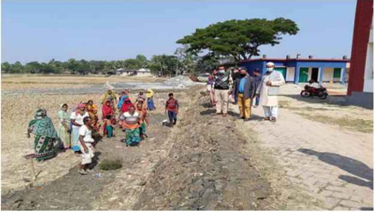
সাতক্ষীরা জেলাধীন বংশীপুর হামিজদী গাইনের বাড়ী হইতে ছাদের গাজীর বাড়ী ও জব্বার শেখের বাড়ী হইতে মধু মন্ডলের বাড়ী পর্যন্ত ইট সোলিং রাস্তার দুঃগার্শে মাটি দ্বারা সংস্কার কাজ পরিদর্শন ।
