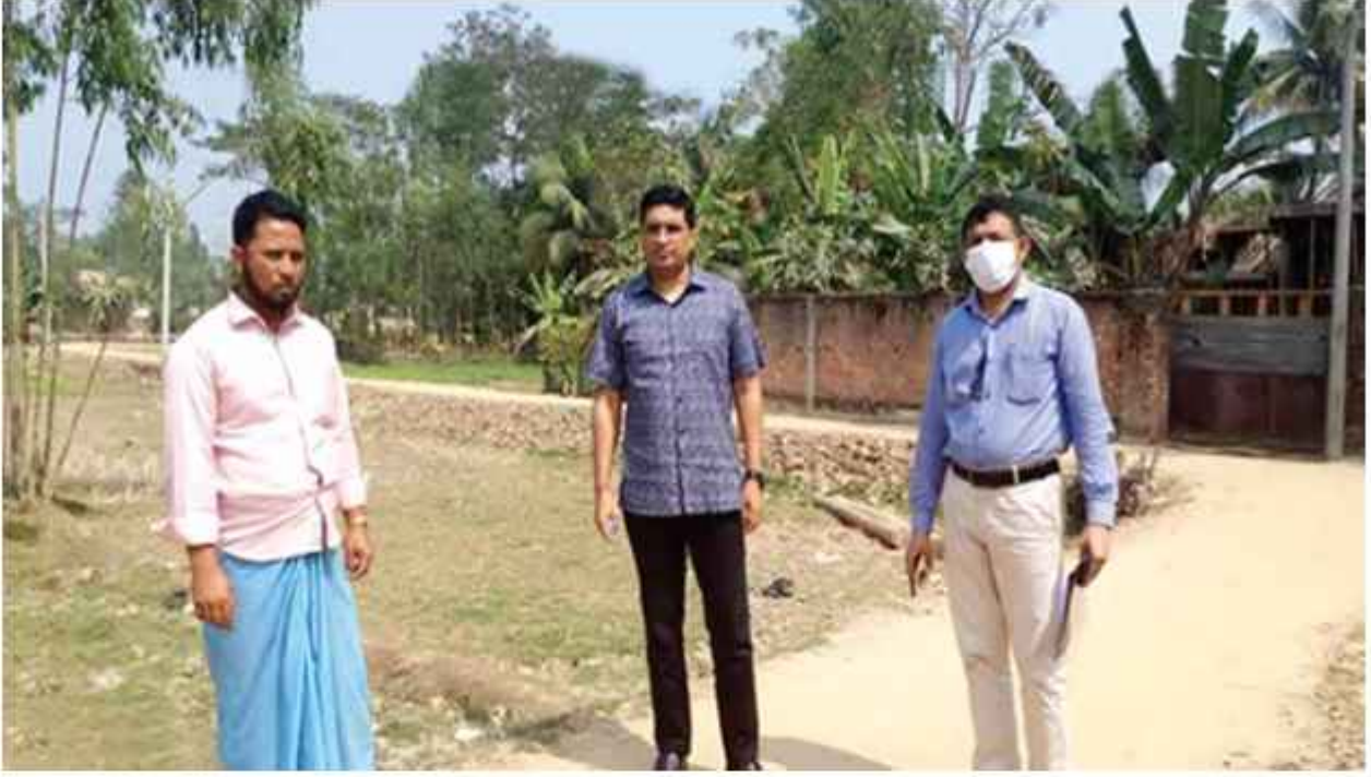
চন্দনাইশ উপজেলায় ইজিপ্সি কর্মসূচির আওতায় রাস্তা নির্মাণ পরিদর্শন।
