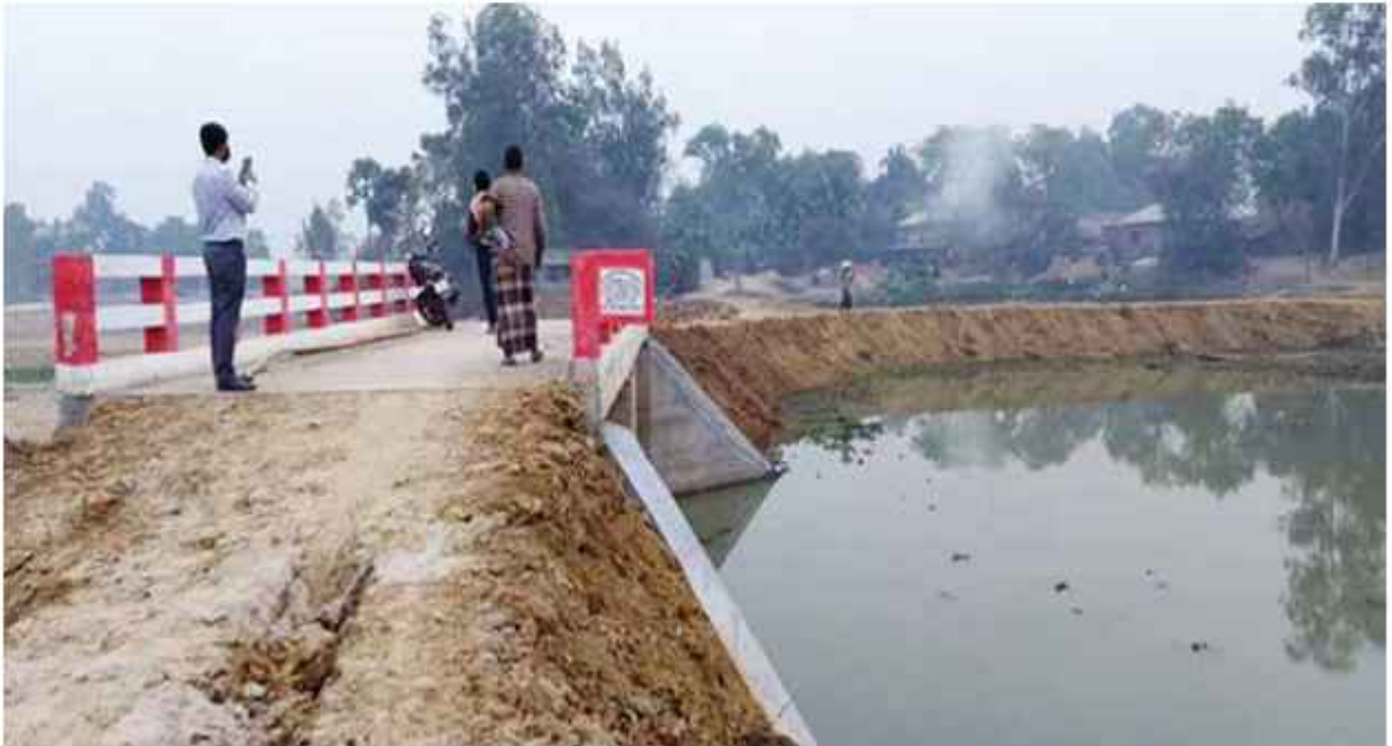
শহরবাড়ি আদেশ আলীর বাড়ি হতে কুশুর বাড়ি ভায়া সালাম এর বাড়ি পর্যন্ত রাজ্য সংস্কার নির্মাণ কাজ পরিদর্শন, ইউনিয়নঃ তাজপুর, উপজেলাঃ সিংড়া, জেলাঃ নাটোর ।
