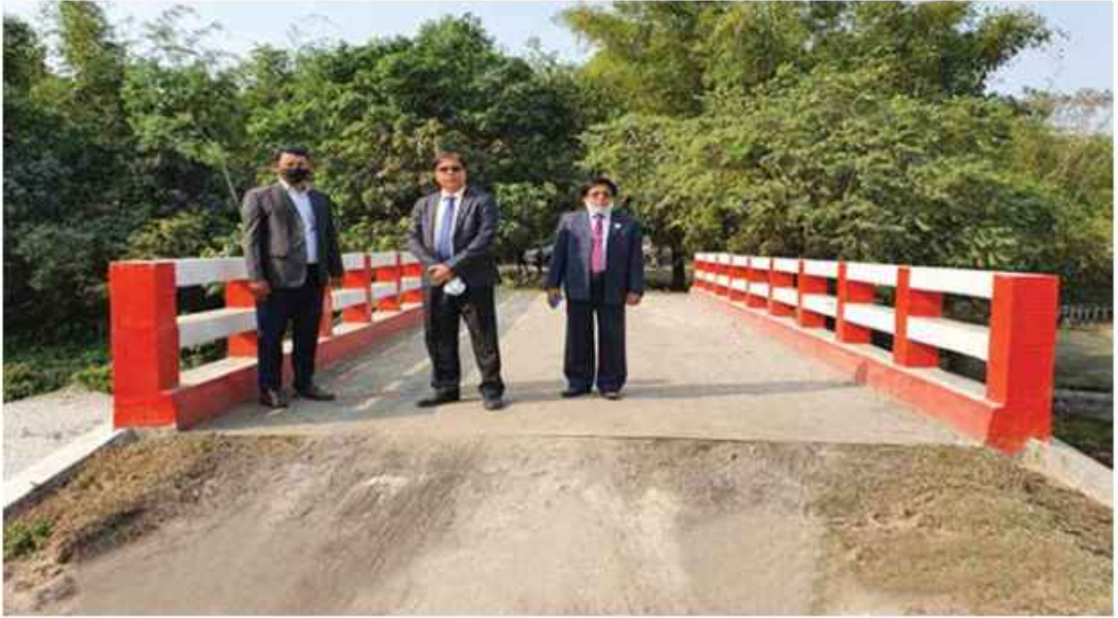
“গ্রামীণ রাস্তায় ১৫ মিটার দৈর্ঘ্য পর্বত সেতু/কালভার্ট নির্মাণ” শীর্ষক প্রকল্পের আওতায় গঞ্চগড় জেলার তেতুলিয়া উপজেলায় নির্মিত সেতু পরিদর্শন।
