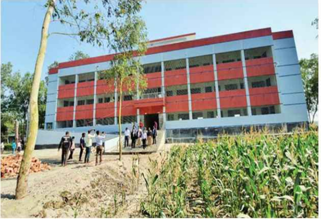
জামালপুর জেলার দেওয়ানগঞ্জ উপজেলায় নব-নির্মিত মৌলভীর চর বালিকা উচ্চ বিদ্যালয় বন্যা আশ্রয়কেন্দ্র পরিদর্শন।
